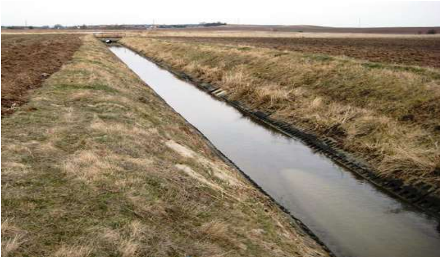
Napřímený, upravený malý vodní tok – Luční potok u obce Úherce (foto: autor, 2008)
